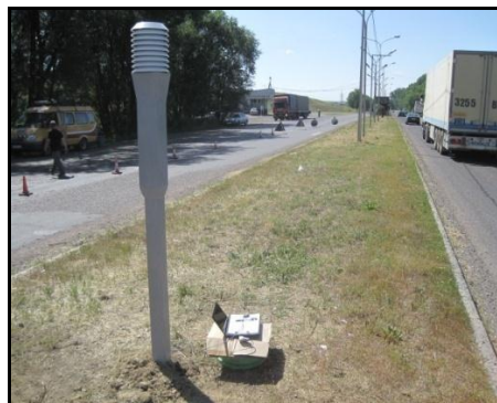
Рис.2. Вид наземной части системы автоматического измерения температуры и влажности
