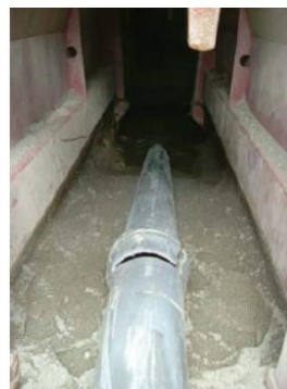
Рис. 2. Обнаружена поднятая труба при реставрационных работах в г. Nagaoka
