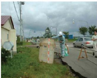
Рис. 1. Поднятый колодец в г. Onbetsu при землетрясении Tokachi-oki 2003 г.
